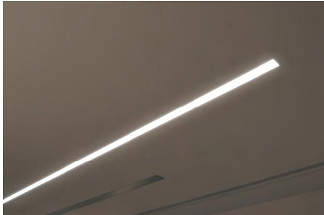
Moduli di dimensioni variabili (lunghezza, altezza e profondità d'incasso) adatti per il montaggio di LED e lampade al NEON, disegnati e fabbricati su misura per consentire la realizzazioni di LINEE di LUCE in pareti e/o soffitti
